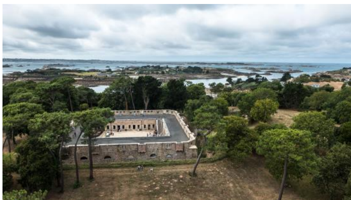
L'ancienne citadelle abrite les Verreries de Bréhat
